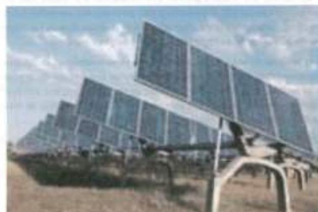
Photo 4 : Suiveurs à rotation bi-axiale (Source : Guide de l'étude d'impact pour les installations photovoltaïques au sol 2011)
