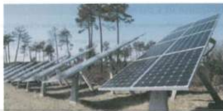
Photo 3 : Suiveurs à rotation mono-axiale (Source : Guide de l'étude d'impact pour les installations photovoltaïques au sol 2011)
