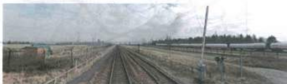
Photo 39 : Voie ferrée au nord de l'aire d'étude immédiate
