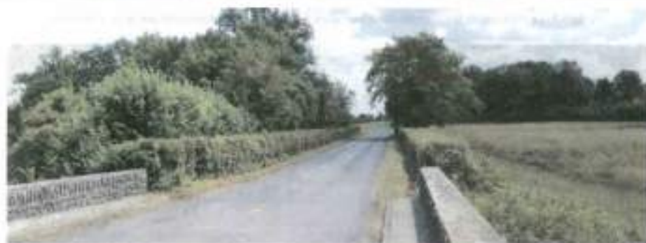
Photo 54 : La traversée du ru d'Anceur à proximité du bourg de la Chapelle-Gauthier
