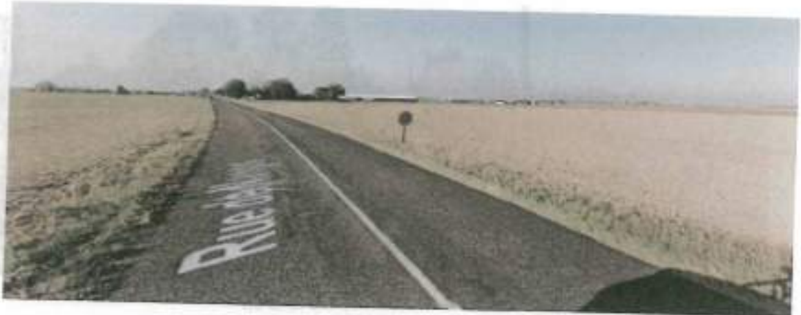
Figure 16 vue depuis la D56 en venant de Clos-Fontaine
