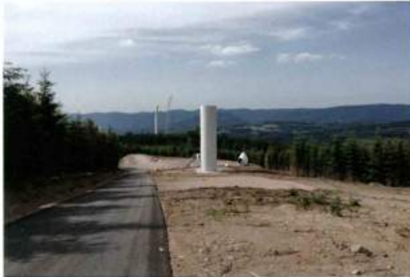
Figure 40 Levage des éoliennes, parc éolien du Bois de Belfays, juin 2017
